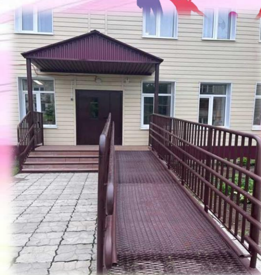
Устройство пандуса и площадки с лестницей
